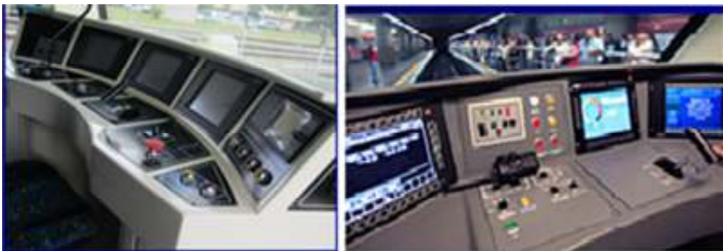
Fig.3 Cabines modernizadas; Utilizando a tecnologia de redes e rádios digitais.
