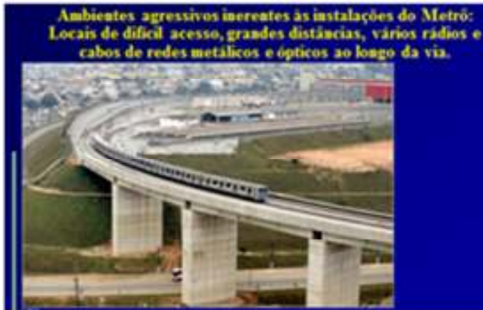
Fig.12 Exemplo de ambiente agressivo inerente às instalações do Metrô; posicionamento dos cabos e rádios ao longo da via.
