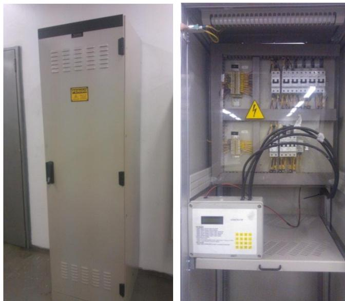
Figura 5 – Vista externa e interna do Painel de Controle de Rotas de Fuga (PCRF) em implantação
