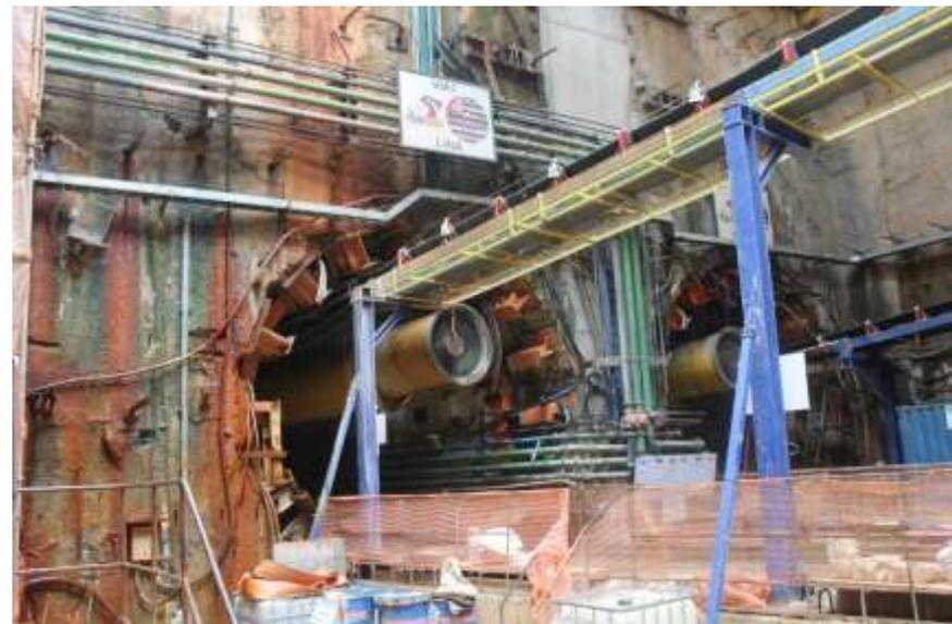
Foto do emboque de túnel da linha 5- Lilás no poço Conde de Itu. No alto do túnel se vê a saída de esteiras para retirada de terra proveniente das escavações do Shield.
