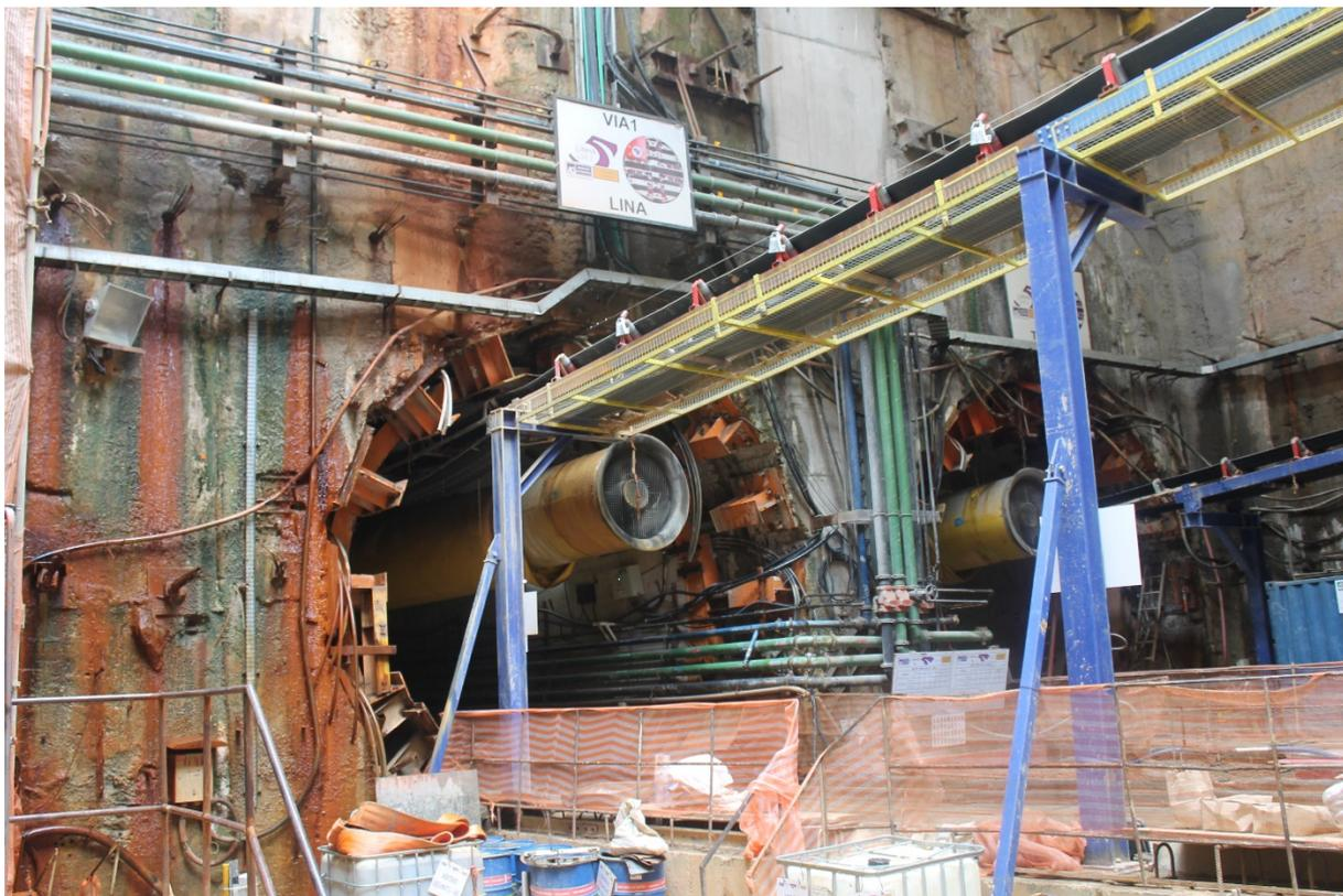
Imagem 7: Foto do emboque de túnel da linha 5- Lilás no poço Conde de Itu. No alto do túnel se vê a saída de esteiras para retirada de terra proveniente das escavações do Shield.
