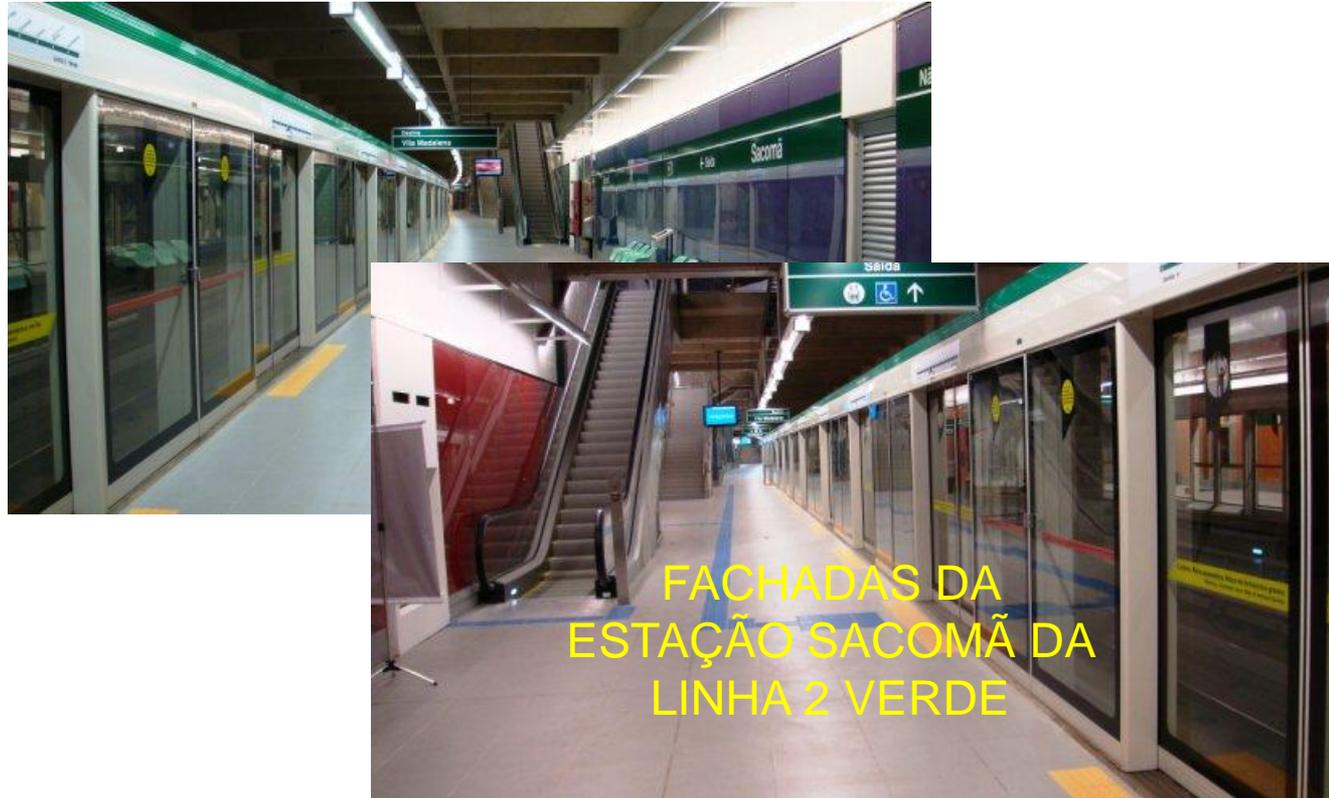
A instalação de portas de plataforma tem sido a solução mais adotada pelos sistemas metroviários para incrementar a segurança na interface entre a plataforma e a via.
