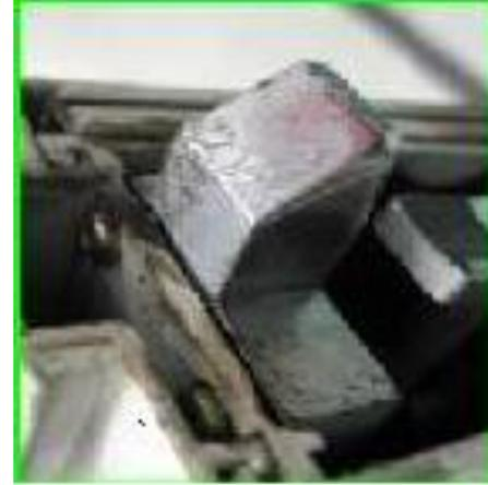
O trinco está fixado na estrutura da folha de porta por apenas dois parafusos.
