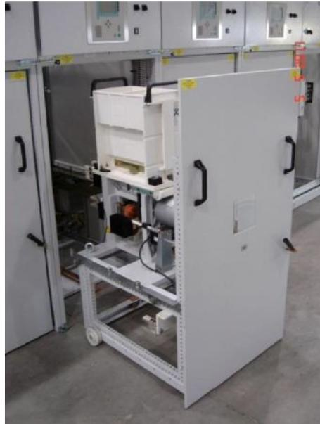
Figura 26 – Detalhe do Disjuntor de 750VCC
