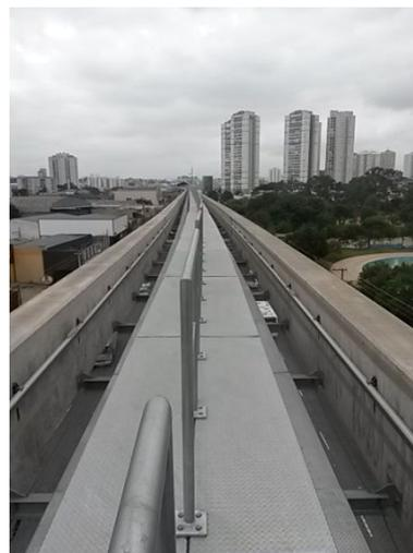
Figura 18 – Trem do monotrilho em testes (foto esquerda). Vias 1 e 2 e passarela de emergência central (foto direita). Notar o espaço exíguo para atuação dos profissionais da manutenção no local.
