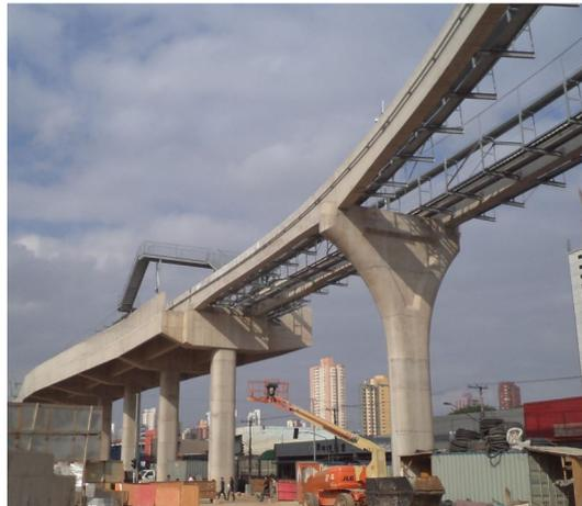
Figura 17 – Detalhes da altura das colunas de concreto do Sistema de Monotrilho da Linha 15-Prata (Trecho de Vila Prudente a Oratório).
