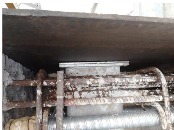
Fotos 43 e 44 – Vista do pivô de travamento posicionado no fechamento com junta de dilatação
