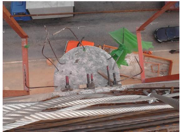
Fotos 35 e 36 – Vista da protensão transversal dos fechamentos de pilares simples
