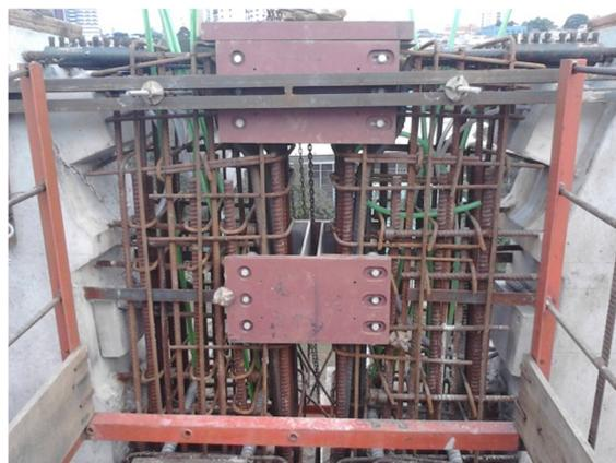
Foto 52 – Vista dos elementos montados na 2ª etapa de fechamento com junta de dilatação
