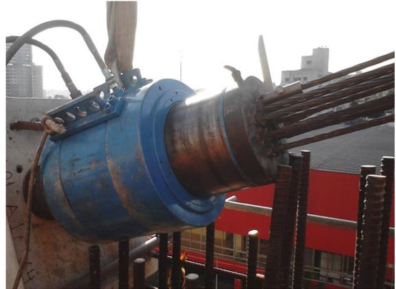
Fotos 39 e 40 – Vista da protensão longitudinal e detalhe das barras Dywidag cortadas para o posicionamento do macaco hidráulico
