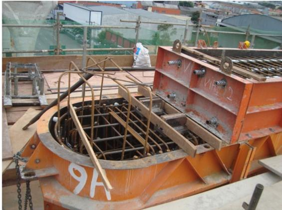
Foto 11 - Detalhe de armação de interface – pilar simples
