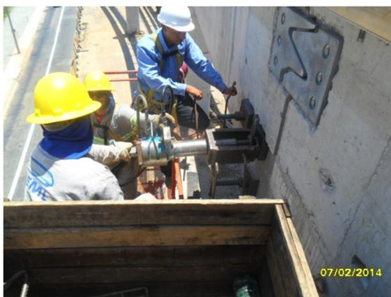
Foto 65 – Protensão do fechamento com junta de dilatação
