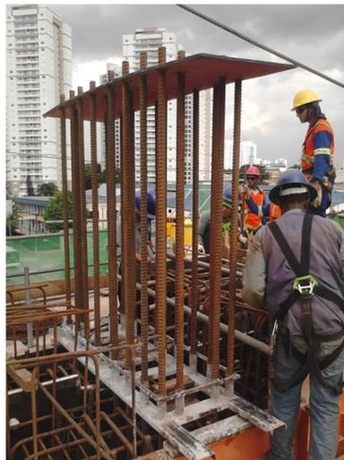
Foto 16 - Vista das barras Dywidag – pilar de junta
