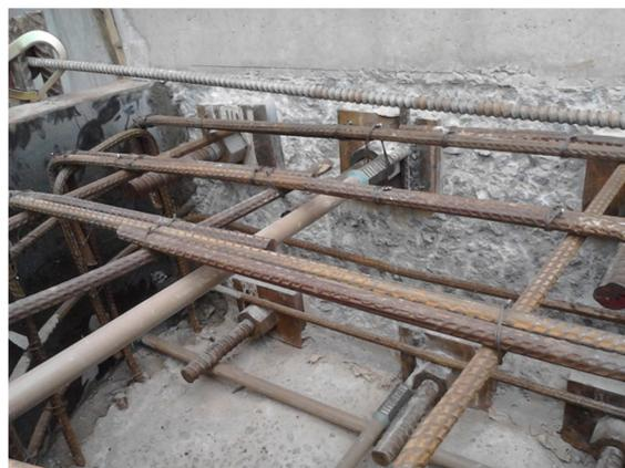
Fotos 66 e 67 – Armação da 3ª etapa de fechamento simples, com vista das placas de ancoragem da protensão
