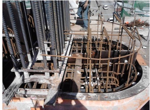
Foto 12 - Detalhe da armação de interface – pilar de junta
