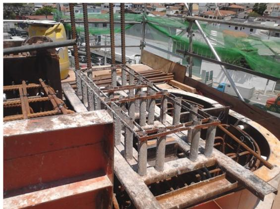
Foto 18 - Vista do gabarito das barras Dywidag – pilar de junta
