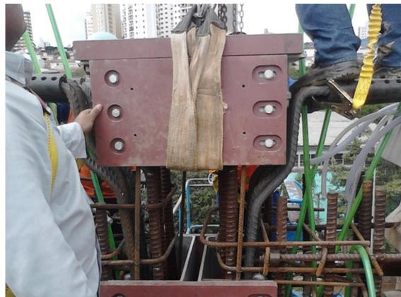
Fotos 55 e 56 – Instalação do gabarito do Finger Plate
