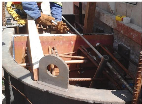
Fotos 70 e 71 – Vista da armação e forma na 3ª etapa de fechamento com junta de dilatação
