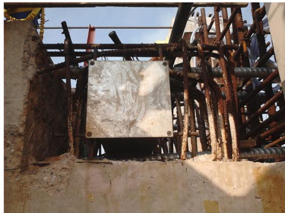
Fotos 41 e 42 – Vista do posicionamento do pivô de travamento no fechamento com junta de dilatação
