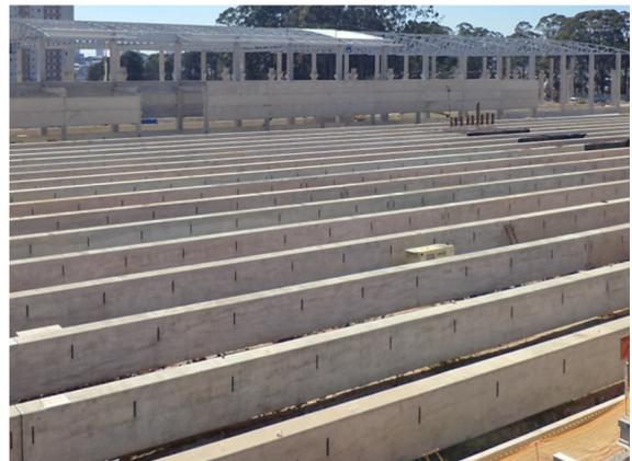
Fotos 95 e 96 – Vista das vigas-guia do estacionamento de trens
