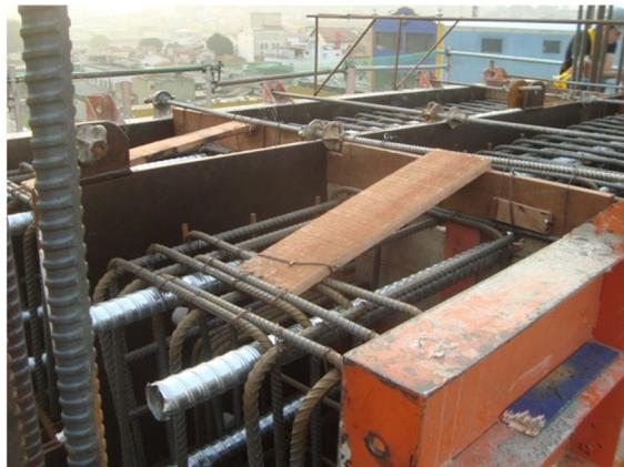
Foto 20 - Vista das bainhas de protensão – pilar de junta
