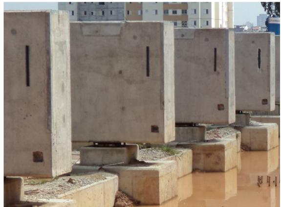
Foto 100 – Vista das vigas apoiadas nos aparelhos de apoio
