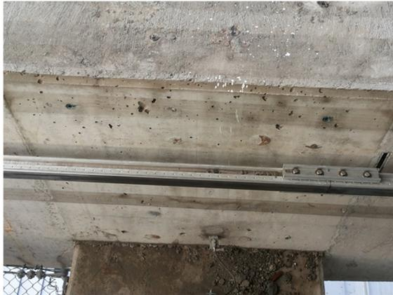
Foto 81 – Vista das bolhas no concreto na 2ª etapa de fechamento – observar marcas do pneu do trem
