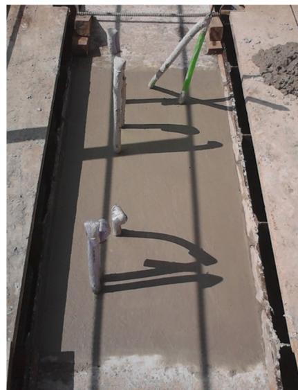
Foto 5 – Concretagem de fechamento entre vigas-guia – comparação com a solda
