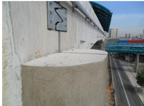
Fotos 75 e 76 – Vista da 3ª etapa de fechamento simples e com junta de dilatação acabados
