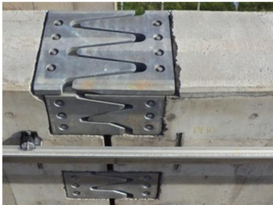
Foto 82 – Vista da quebra da quina do concreto junto o Finger Plate
