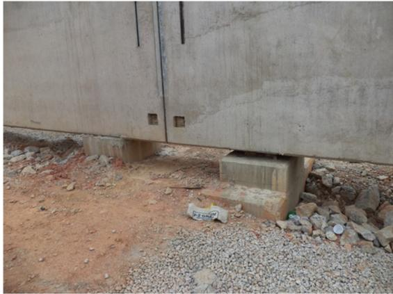
Foto 97 – Vista dos dois tipos de apoio das vigas-guia
