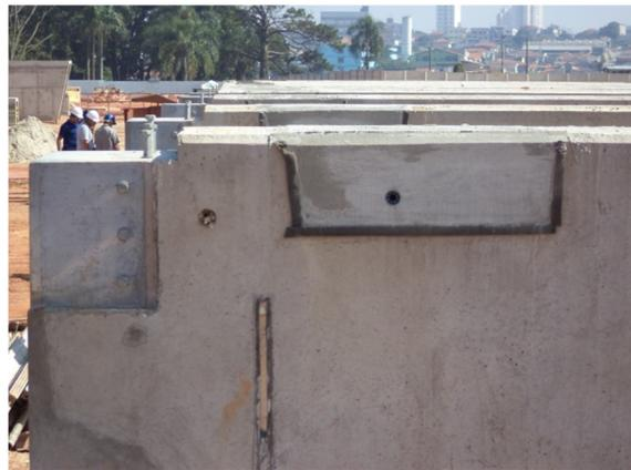
Fotos 101 e 102 – Vista de extremidade engastada da viga-guia
