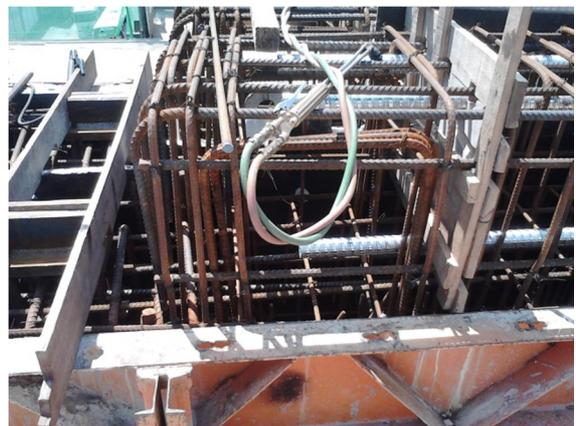
Fotos 13 e 14 – Vista ao centro das barras formando um quadrado para a posterior instalação do pivô de travamento
