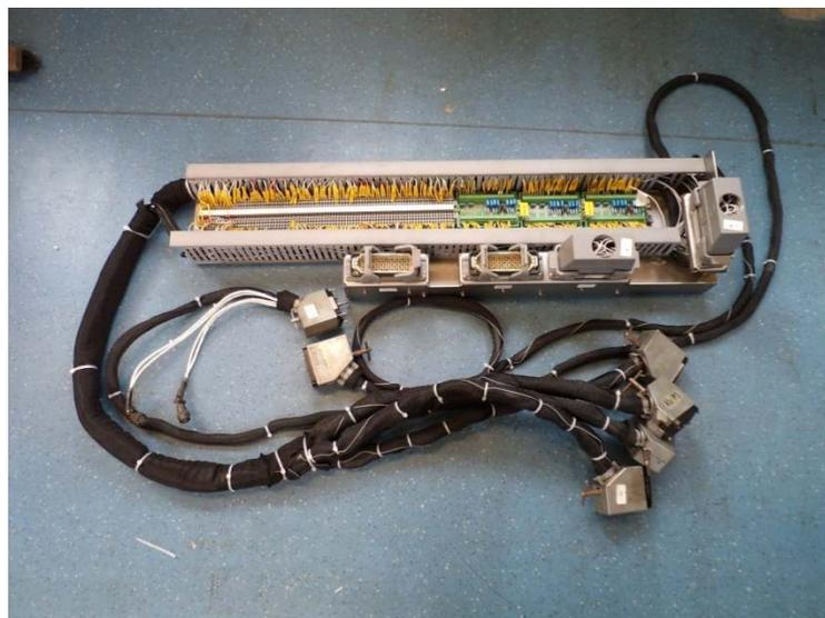
Módulo de terminações e conexões (MTC).
