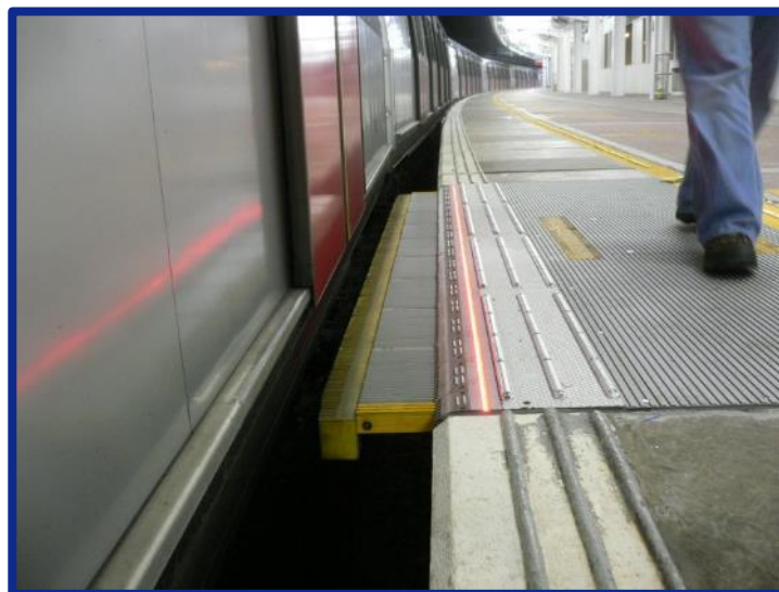
Exemplo de metrô asiático com prolongadores mecânicos na plataforma
