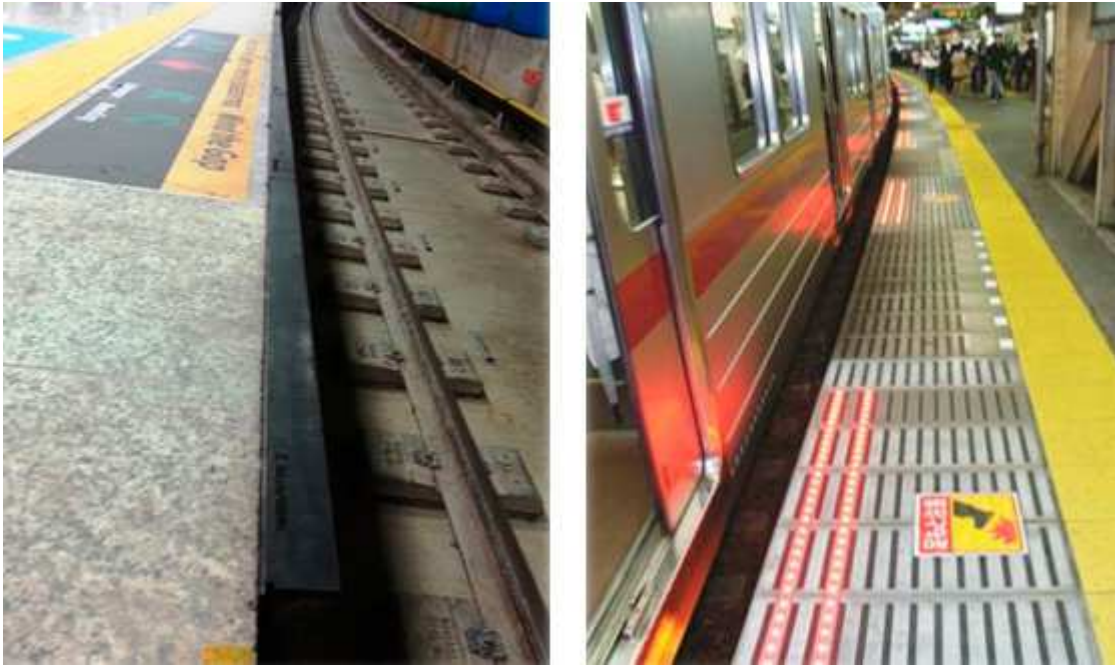
Figura 1- Exemplos de soluções para o vão entre o trem e a plataforma, incluindo complemento fixo e linhas luminosas.
