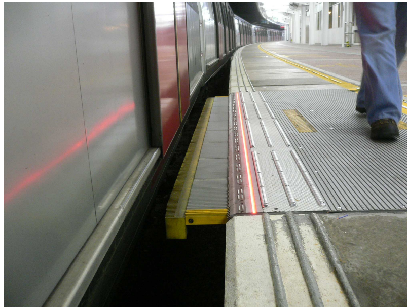
Figura 3 - Exemplo de metrô asiático com prolongadores mecânicos na plataforma (METRÔRIO, 2014).
