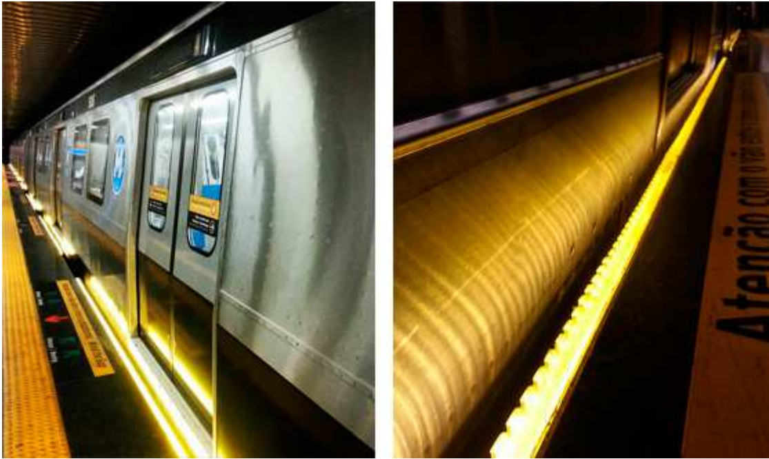
Figura 2 – Plataforma com Gap Filler Iluminado
