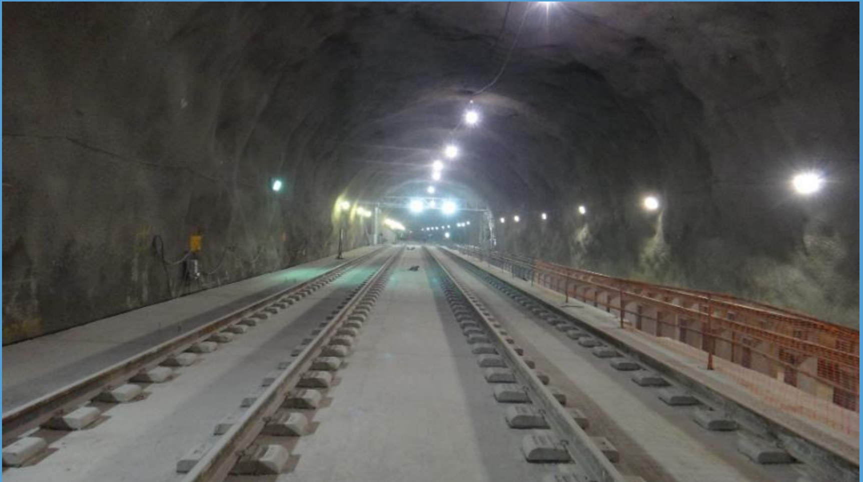
Metrô Rio de Janeiro – Linha 4
