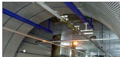
Sistemas de Catenária (tipo rígida)
