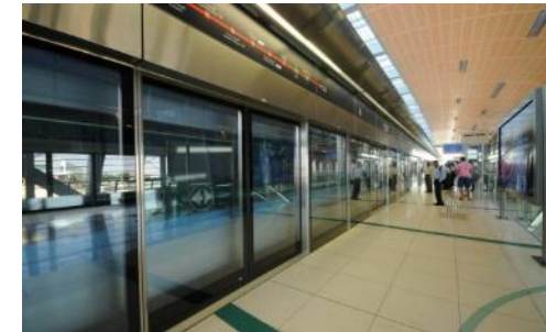
Sistemas de Portas de Plataforma
