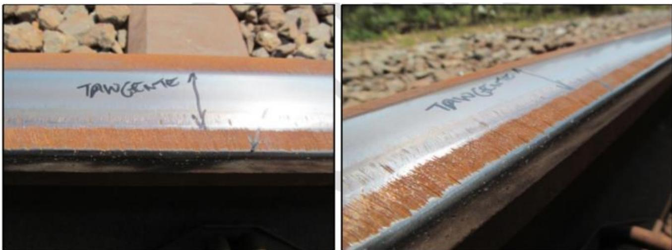
**Figura 23:** Desgaste lateral em seção de via tangente, sendo uma indicação de pobre alinhamento dos truques nas tangentes
