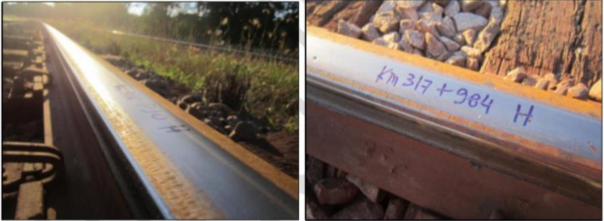
**Figura 17:** Exemplos de dois pontos de contato encontrados em trilhos externos de curvas na EFVM
