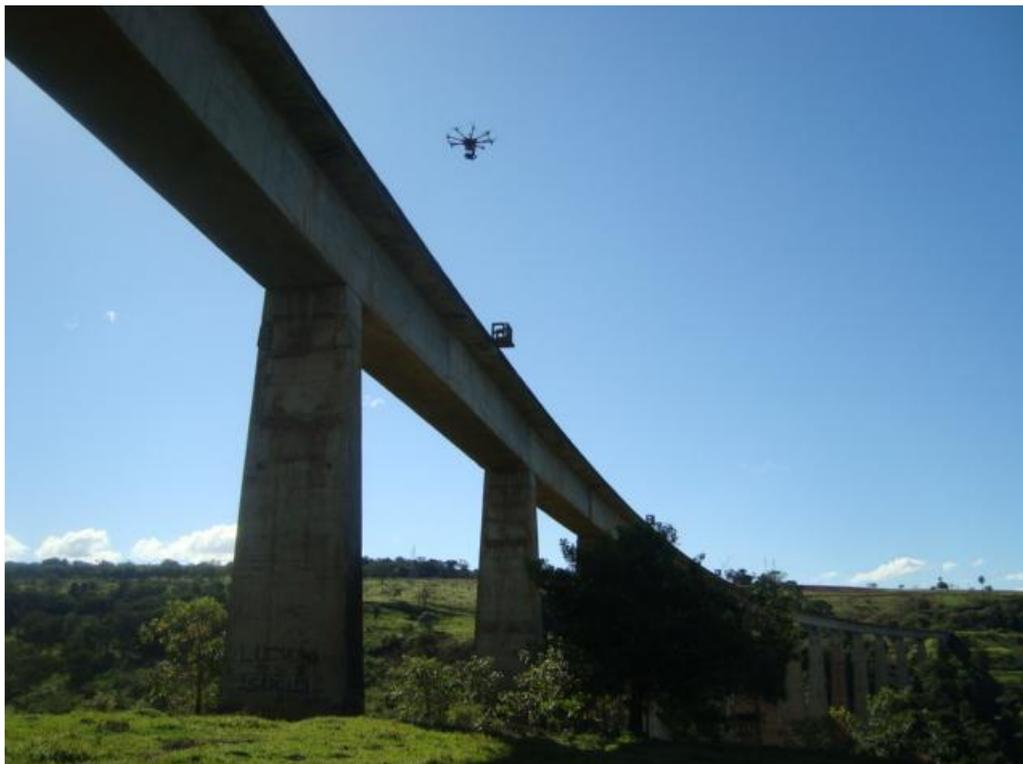
Figura 1 – Drone executando inspeção em viaduto ferroviário em Araguari/MG.
