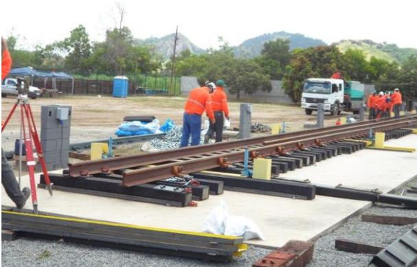
Figura 20 – Alinhamento dos trilhos de encosto com suporte topográfico.
