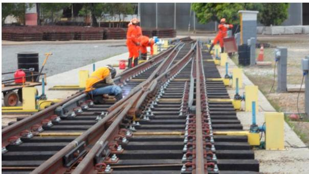
Figura 24 – Processo de soldagem dos Shoulders e das cantoneiras de fixação da bitola.
