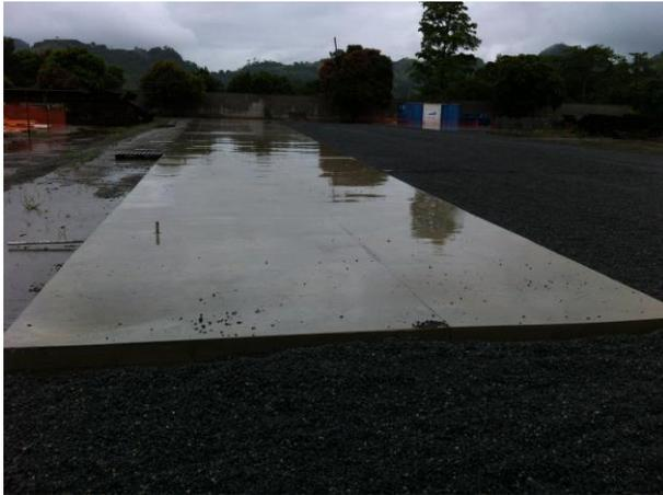
Figura 7 – Base do AMV esquerdo logo após a concretagem em processo de cura.
