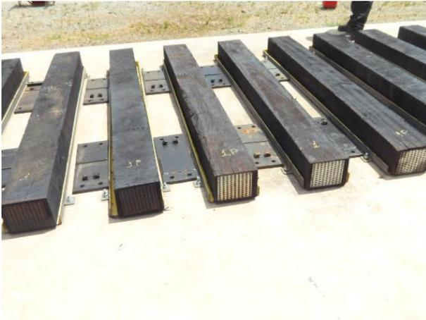
Figura 16 – Posicionamento da placas para serem fixados nos trilhos
