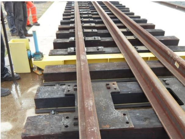
Figura 19 – Posicionamento das placas entre o trilho e o dormente.
