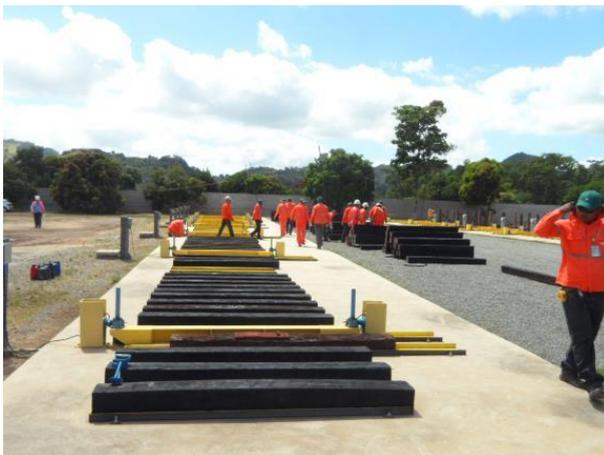
Figura 15 – Posicionamento dos dormentes na calha.
