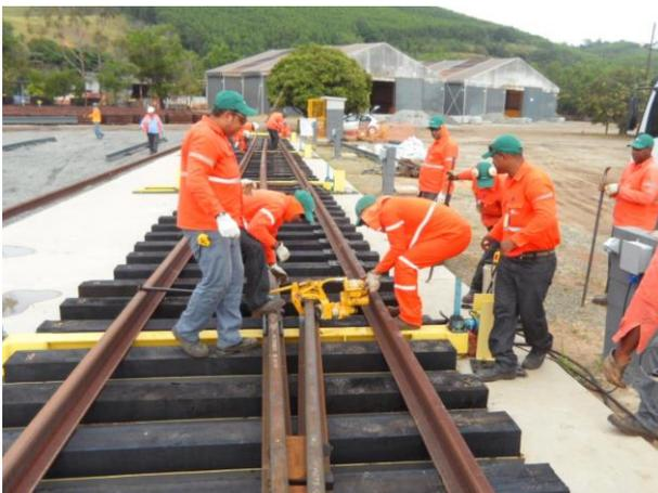
Figura 21 – Corte e furação dos trilhos para montagem do AMV.
