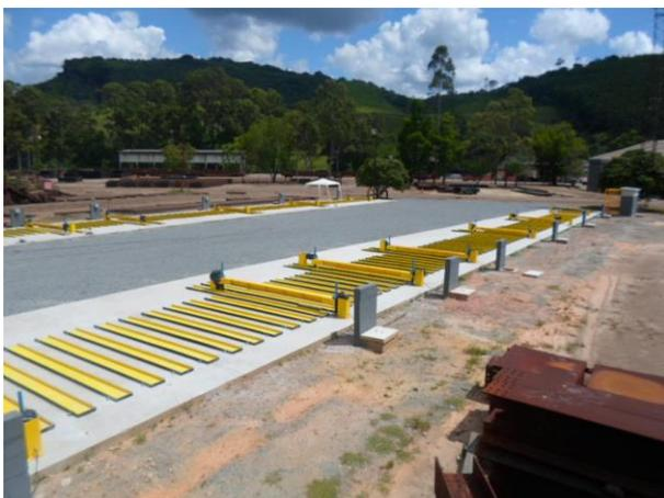
Figura 8 – Visão geral da base com as calhas e os macacos fixados.
