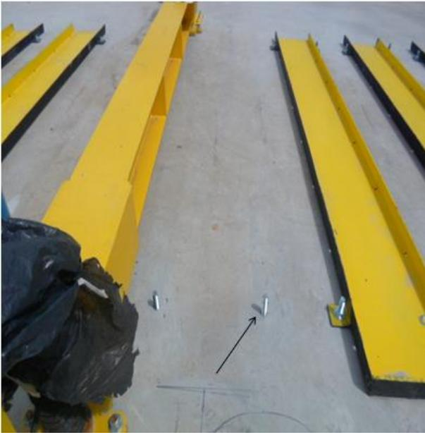
Figura 9 – Detalhe demonstrando os parafusos do tipo “Parabolt” fixo no concreto.
