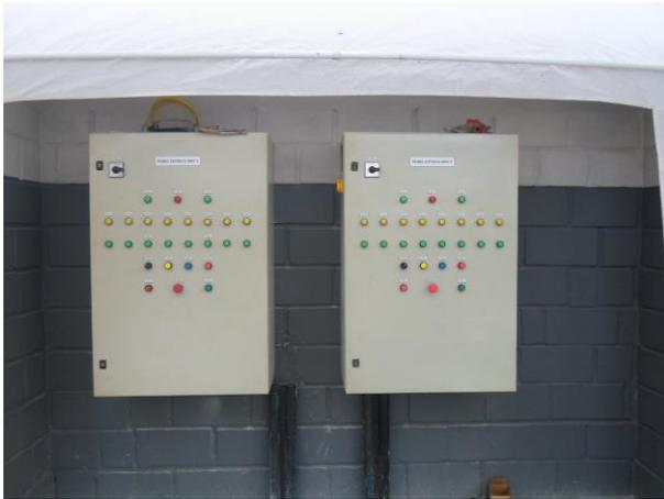
Figura 14 – Painéis de controle das unidades de elevação.
