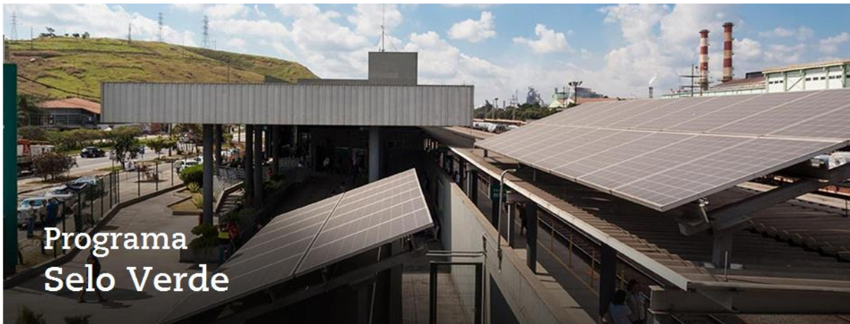
Figura 17: Pannel de geração de energia solar na Estação Ferroviária de Intendente Câmara
