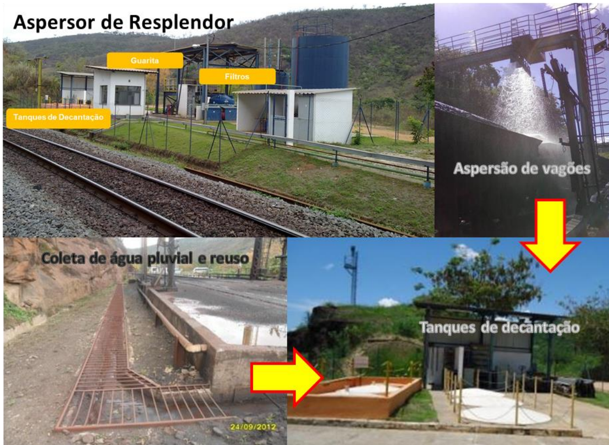
Figura 16: Sistema de Aspersão de Vagões
