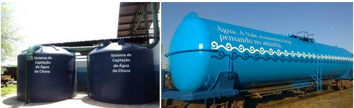
Figura 18: Sistemas de aproveitamento de água pluvial da Oficina de Vagões e do Pátio Ferroviário de Costa Lacerda, respectivamente
