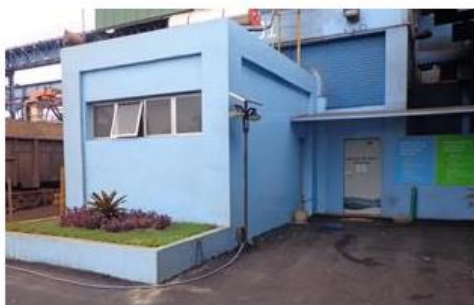
Posto de Manutenção de Descarga do Porto
