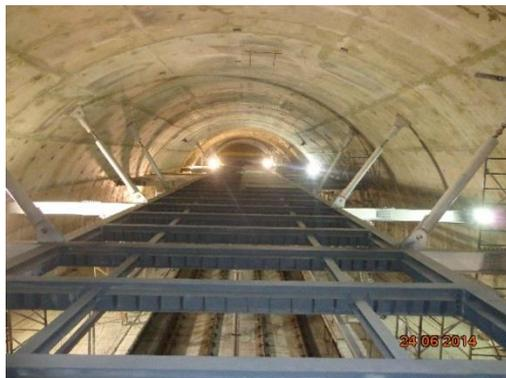
Monta-se, na sequência, as vigas complementares dos eixos transversais, estas também fixadas à estrutura principal e à abóboda do túnel sendo que, parte delas, servem de apoio às estruturas das escadas fixas e rolantes das plataformas.
