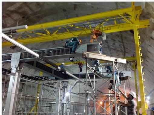
Concluída esta etapa, segue a montagem das vigas longitudinais, demais vigas transversais e estruturas secundárias, em cada eixo, do centro em direção às extremidades dando sequência à montagem das peças complementares e fixação definitiva, utilizando-se soldas e parafusos.
