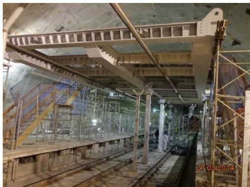
Passa-se, então, à instalação dos tirantes de sustentação, presos aos olhais soldados às vigas da estrutura do mezanino e às chapas pré-fixadas com insertos metálicos na abóboda do túnel. As soldas de filete são verificadas por ensaio de líquido penetrante, conforme critérios pré-estabelecidos. Foram realizadas provas de carga nos insertos da ancoragem dos tirantes do mezanino.
