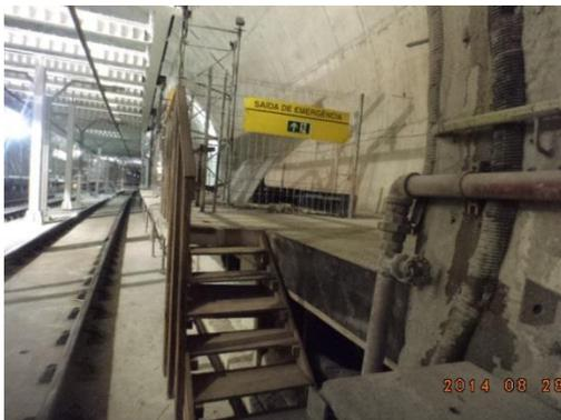
Fotografia 3: Segregação de áreas de trabalho restritas e isolamento da saída de emergência (Estação Higiênópolis); Data: 25/03/2015; Fonte: Acervo Próprio.
