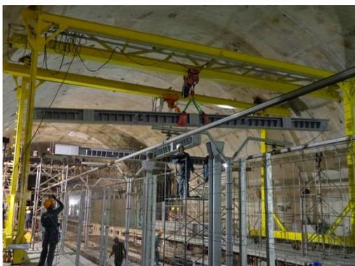
Fotografia 9: Apoios provisórios (Estação Oscar Freire); Data: --/2014; Fonte: Acervo Próprio.
