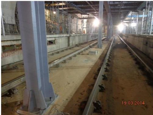
Foram posicionadas torres metálicas de escoramento em ambas as plataformas, alinhadas aos pilares do vão central, para apoio auxiliar e provisório das vigas até a sustentação final da estrutura por meio dos tirantes permanentes, fixados aos olhais das vigas e aos insertos localizados na abóboda do túnel.
