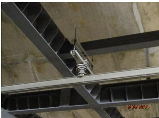
A pintura da estrutura é composta pela aplicação de primer epóxi poliamida bi componente, na fábrica. Na obra, aplica-se tinta intumescente para proteção passiva contra incêndio, seguida por 2 camadas de tinta de acabamento acrílica de alta performance, conforme especificações de projeto.
