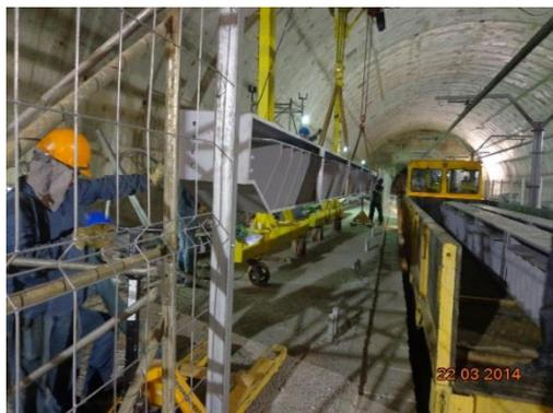
Para a operação de içamento das peças foram utilizados 2 (dois) pórticos rolantes de grande porte, equipados com talha elétrica com capacidade para suportar 3 toneladas, cujas rodas corriam apoiadas nas lajes de ambas as plataformas.
