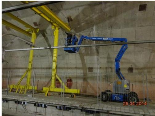
Estes mesmos pórticos foram utilizados para içar e posicionar os perfis para montagem da estrutura, conforme descrito no tópico seguinte.
