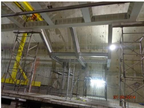
A partir desse estágio, torna-se possível a transferência dos pontos de fixação das catenárias, dos postes de sustentação provisórios para a superfície inferior das vigas do mezanino, em caráter permanente.
